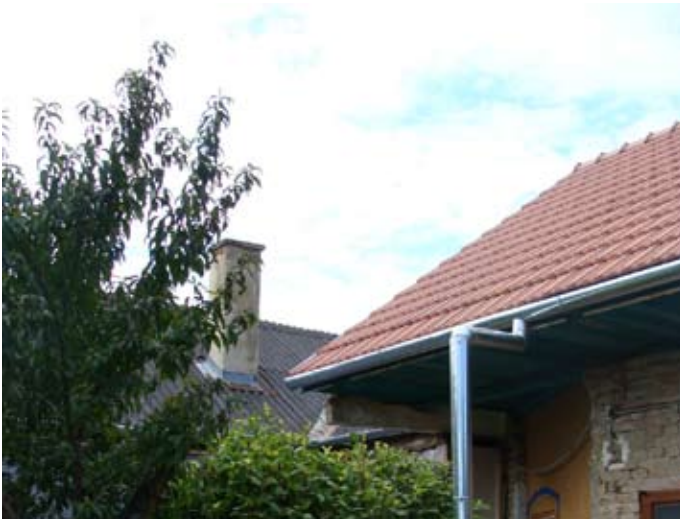
KALTDACH NEU: Plus 2 Regenrohre in ausreichender Dimension
