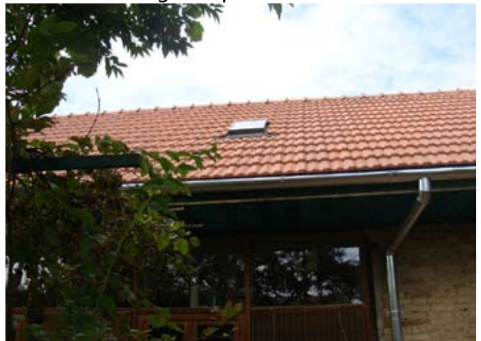
KALTDACH NEU: PLUS sämtlicher Blechar- beiten und ALLE Regenrinnen NEU (Hof)
