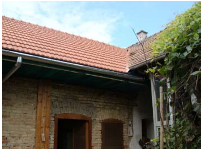
KALTDACH NEU: Plus REPARATUR undich- te Verblechung Hauptkamin
