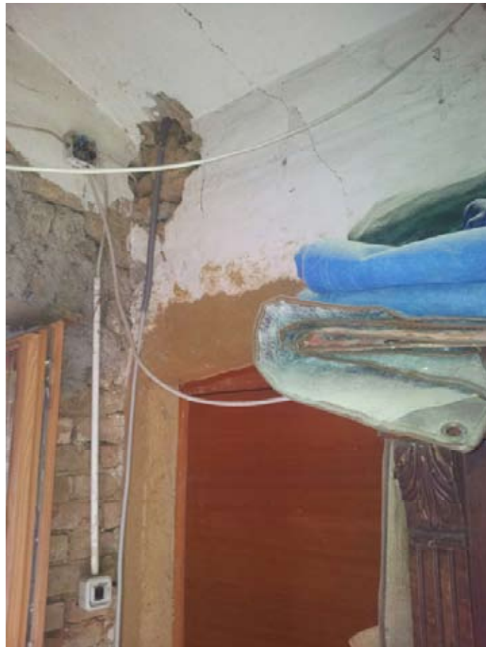
Verlegeart nicht korrekt- kein Dosen- deckel vorhanden; Schalter nicht montiert - hängt lose rum
