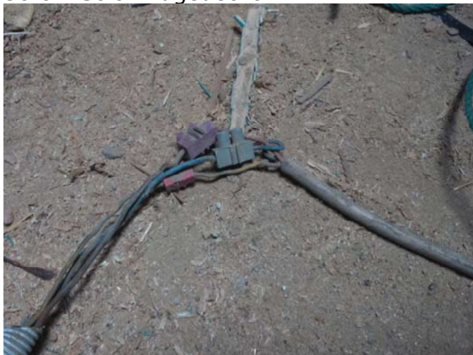
Kein Klemmdose vorhanden. Klemme lag unter ca 50 cm Stroh
