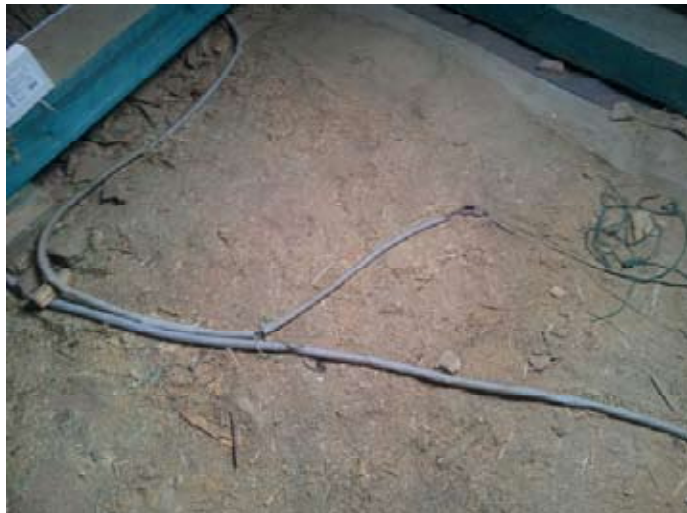
Verlegeart unkorrekt - Drähte liegen frei, keine Klemmdose über Klemmverbindung
