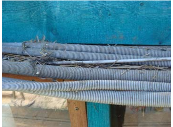
Unterputz Kabelrohre porös durch UV
