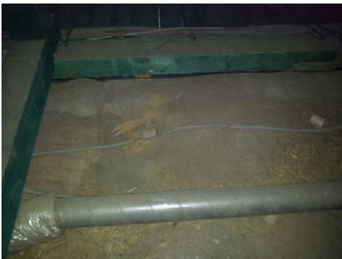
Verlegeart unkorrekt - Drähte liegen frei
