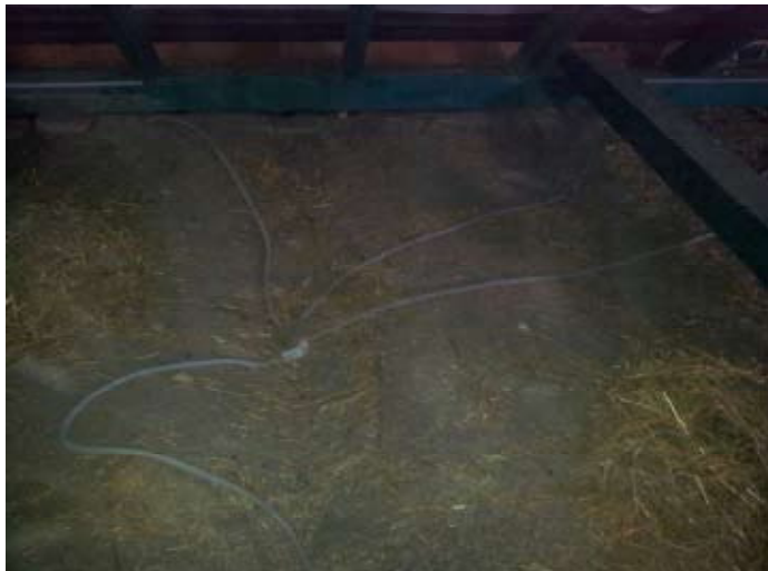
Verlegeart nicht korrekt - Dose war mit ca 50 cm Stroh zugedeckt
