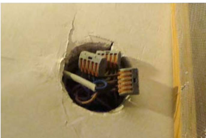
SANIERT: Sämtliche Leitungen geerdet..
