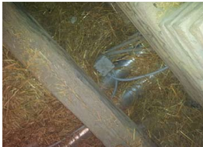
Verlegeart nicht korrekt- kein Dosen- deckel vorhanden; Schalter nicht montiert - hängt lose rum
