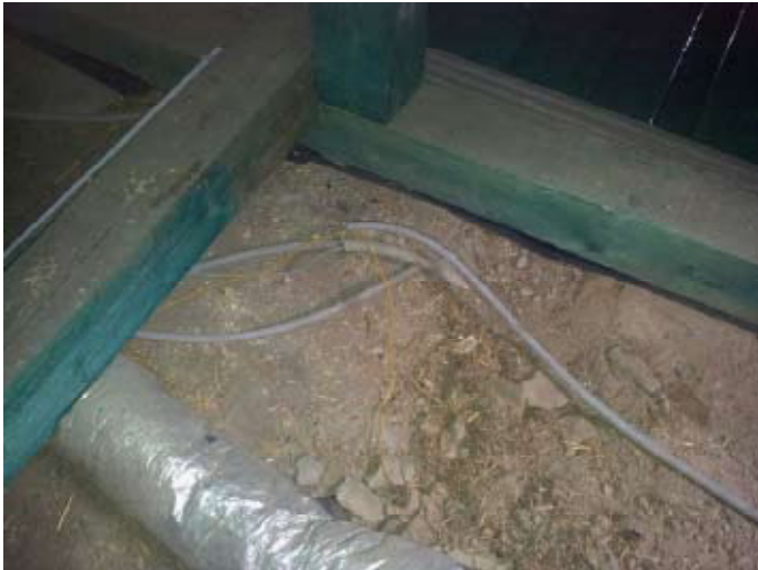
Verlegearbeit nicht korrekt
