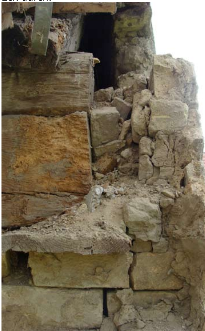
Die Lösung der Mauer aus dem Verbund lässt sich bereits erkennen
