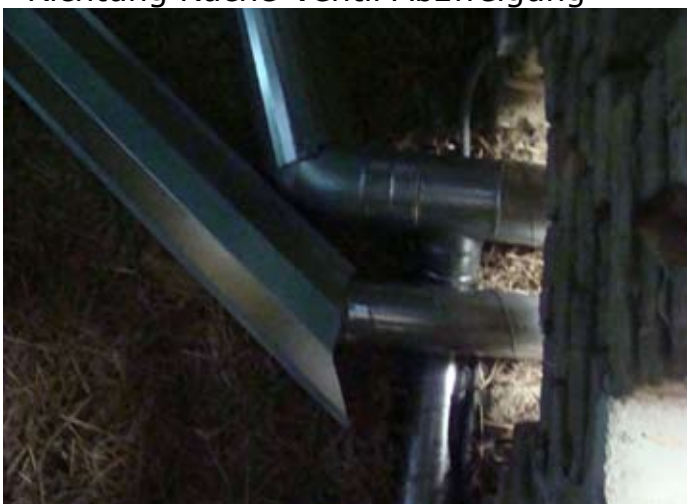
ORT: Dachstoß - Knoten NEU Bad, NEUE Leitung zum NEUEN Ventil Speis
