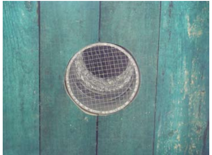
ORT: Laubengang: Abluftventil AUSSEN, gesichert
