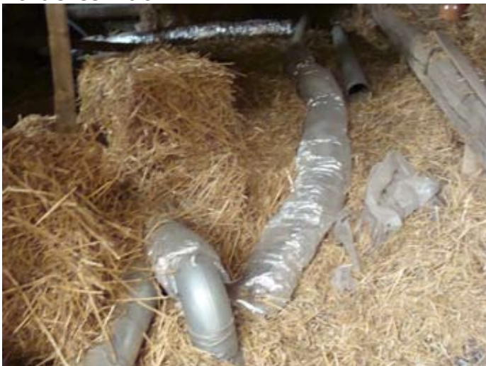
ORT: Knotenpunkt Vorzimmer, vorderes Dach
