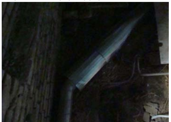
ORT: Leitung NEU, Schalldämmung NEU - Ventil Speis
