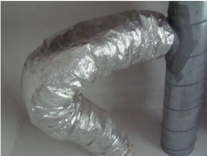
ORT WC- Schallschutz zum Wandventil im Ex-Schlafzimmer professionell saniert
