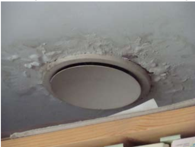
ORT: JU-Ex-Zimmer - Kondenswasserschaden ab 2011/12
