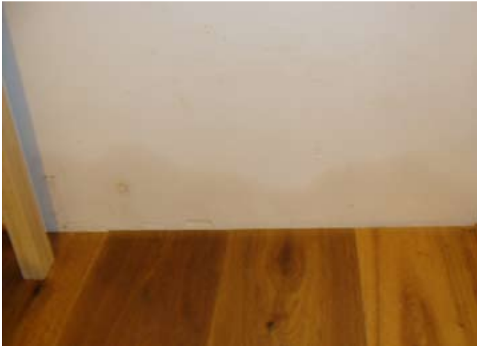
ORT: Speis NEUE Wände - aufsteigende Feuchtigkeit - keine Horizontal-Isolierung
