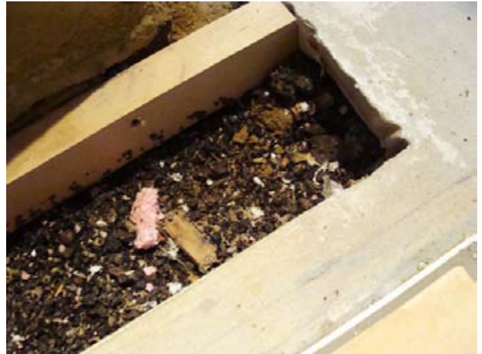
Sämtliche Schächte mussten monatelang freigelegt bleiben
