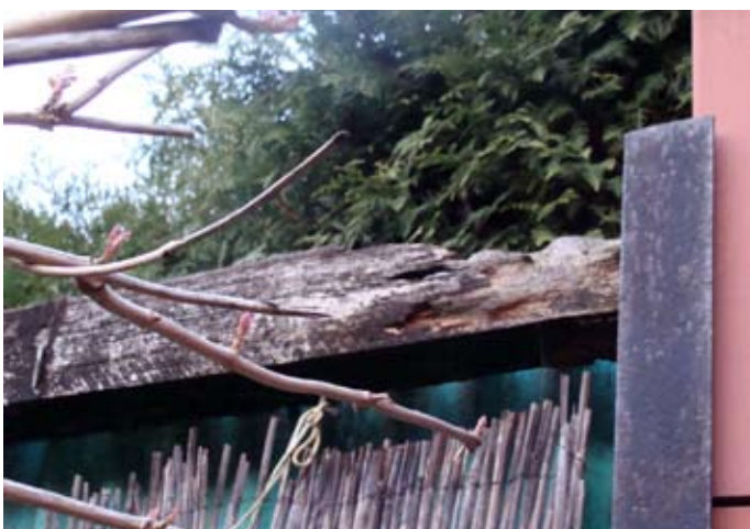
VERWAHRLOSUNG: Vermorschter Balken im Innenhof, einer ist bereits ersetzt
