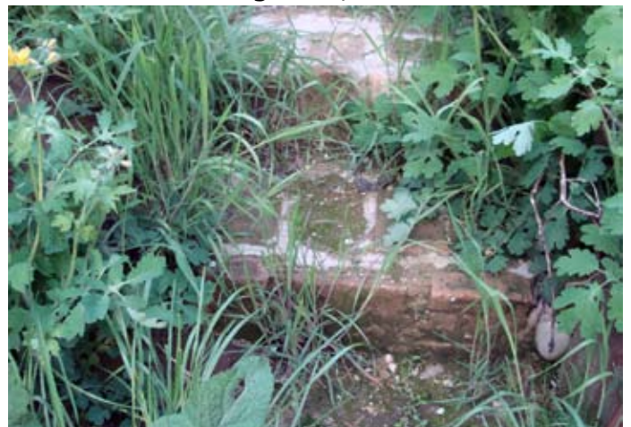
LEICHTSINNIGKEIT: Schiefe rutschige Ebene aus Holz, durch gemauerte Stufen ersetzt.
