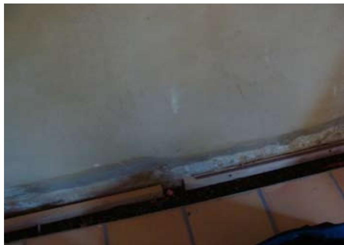
Putzschäden durch unsachgemäße Putzarbeiten
