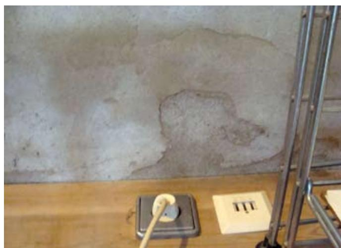
KEINE Horizontalisolierung W-Front - trotz völlig neuem Bodenaufbau
