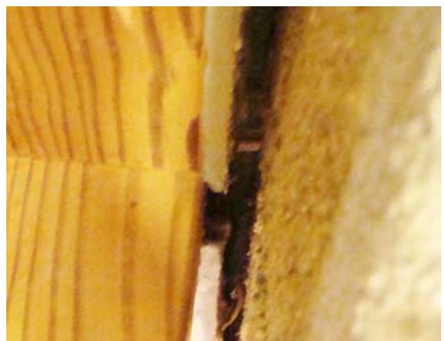
Wundervolle Kältebrücke bis in den Dachboden - inkl. Sichtkontakt, W.Verlust 3
