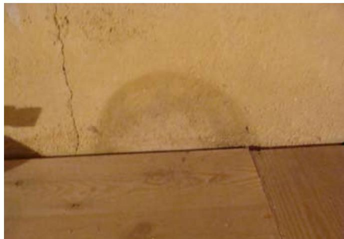
Mangelhafte/fehlerhafte Horizontalisolierung O-Front
