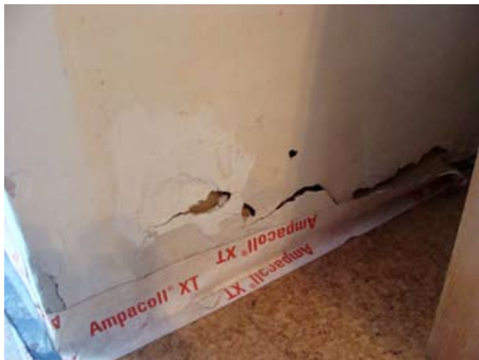
ORT: Ehemaliges Kinderzimmer: N-Front - Mangelhaft, Fehlerhafte H-Isolierung?
