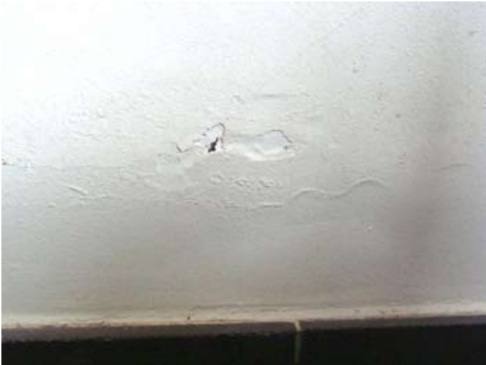
ORT: BAD: Wasserschaden: Fehlende H- Isolierung, Siphon, Waschmaschine
