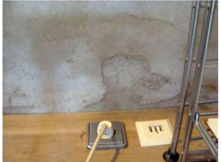
ORT: Ehem. Büro - Feuchteschäden: W-Seite, Ecke Nord
