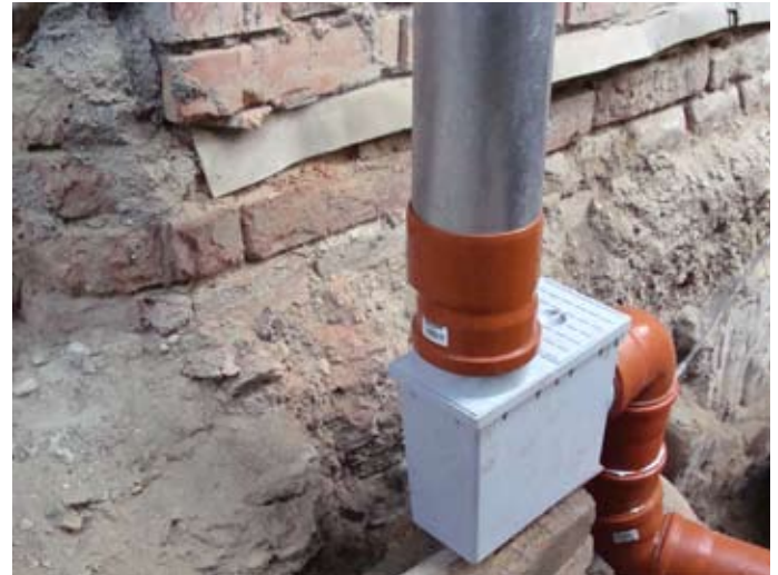
ORT: O-Front - Horizontalisierung Bitumenbahn über Niveau
