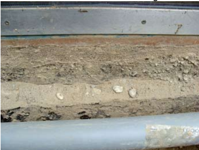
ORT: O-Front - Horizontalisierung mit Bitumenanstrich Holzglasfront
