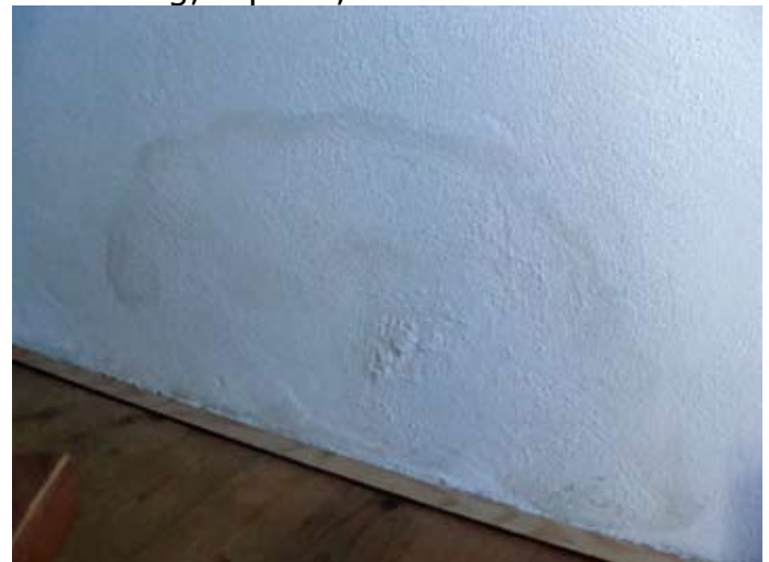
ORT: Ehemaliges Schlafzimmer - trotz Hinterlüftung von 3cm Schimmelbildung
