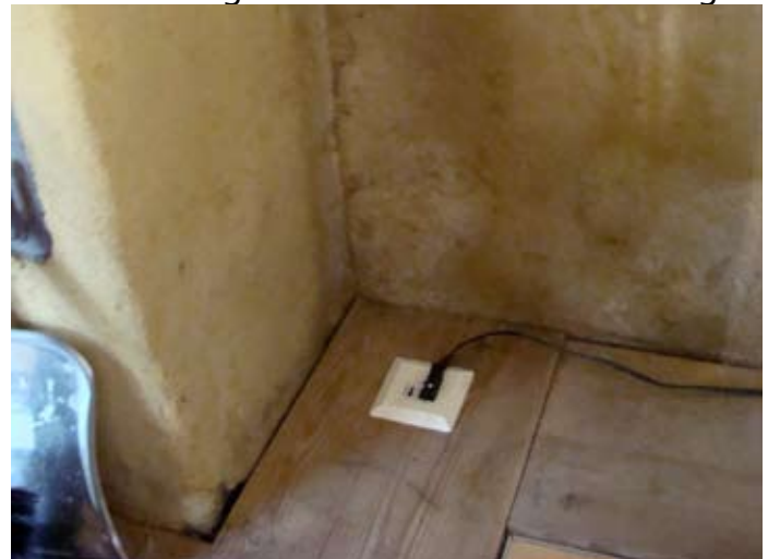
ORT: Ehem. Büro - Feuchteschäden: S- Seite, Ecke Kamin
