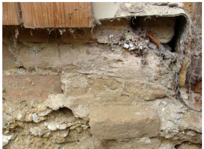
ORT: O-Front: Bitumenisolierung im Türbereich, Abstellraum - Detail
