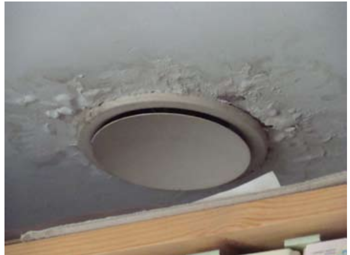
ORT: Ehemaliges Kinderzimmer 2: Kon- denswasserschaden: Lüftungstilllegung
