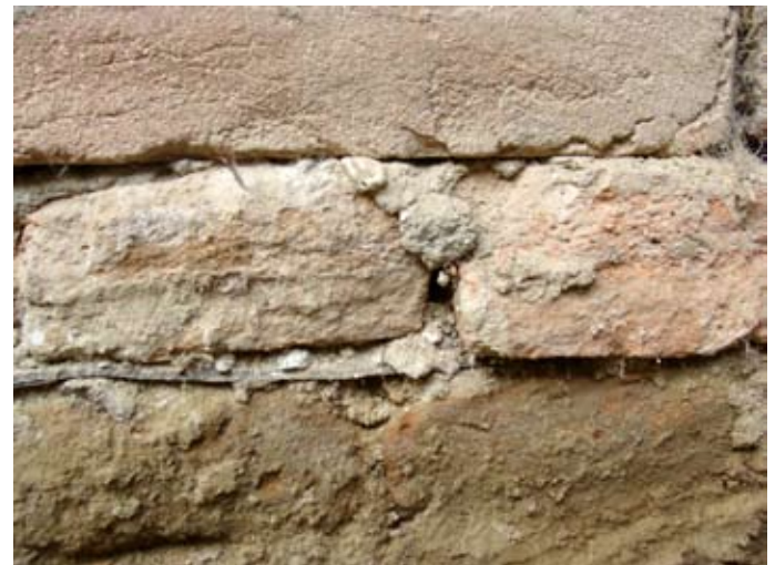
ORT: O-Front - Horizontalisierung mit Bitumenbahnen im Mauerwerk
