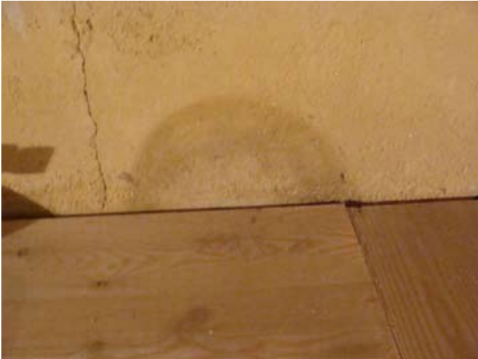
ORT: Ehem. Büro - Feuchteschäden: O-Seite, S-Ecke
