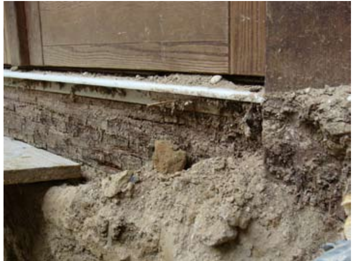
ORT: O-Front - Horizontalisierung Türbereich N im Detail - unzureichend
