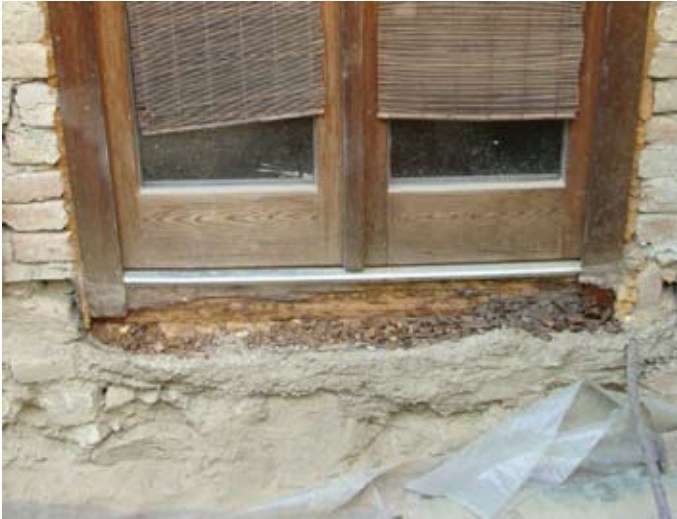
ORT: O-Front - Horizontalisierung Tür Abstellraum - Bitumenmatte abgesenkt
