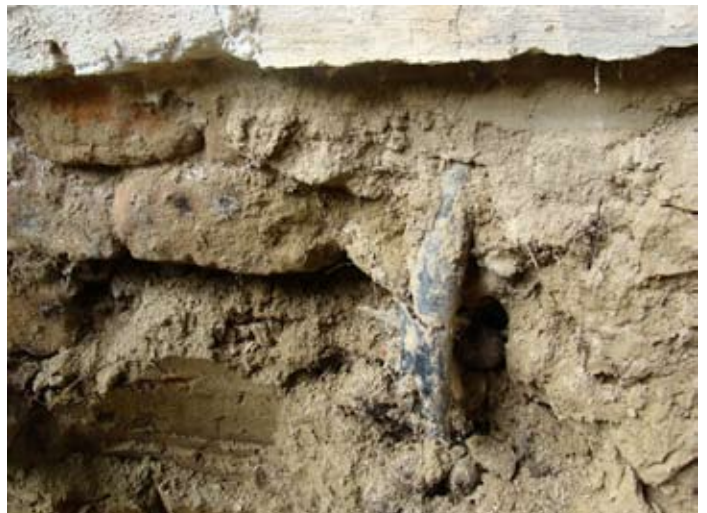
ORT: Heizraumbereich - ohne Horizontal- isolierung: 2015 belüftet
