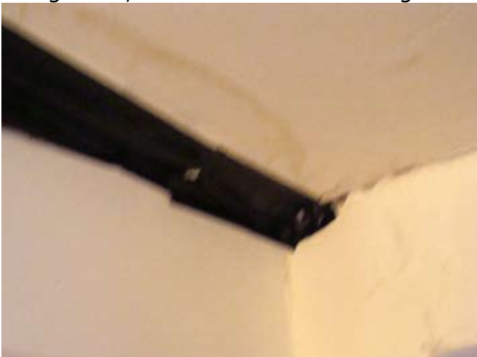
ORT: Küche: Wasserschaden: Dachstoß undicht
