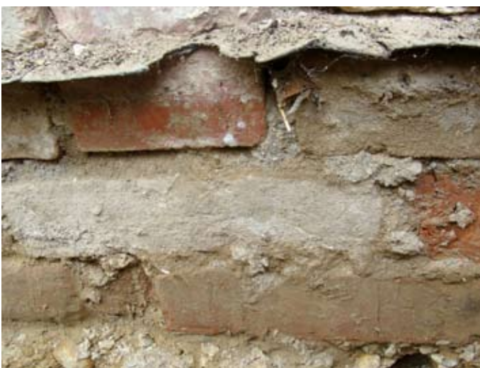
ORT: O-Front - Horizontalisierung 2-3 Ziegel Abstand zum Erdreich (Fundament)
