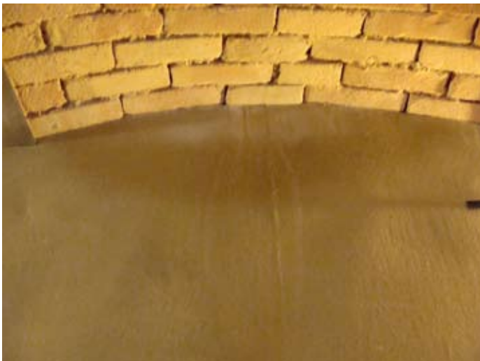
ORT: Ehem. Büro - Feuchteschäden: W-Seite, Dach undicht 2
