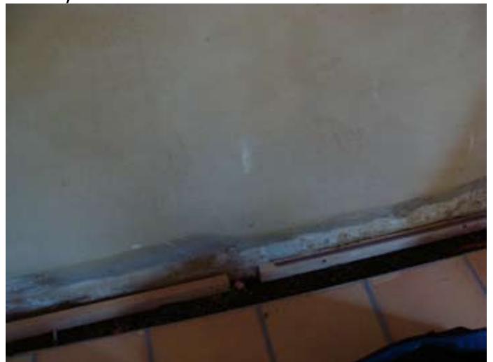
ORT: Ehem. Büro - Feuchteschäden: N-Seite, Putz durchgeschnitten 2014 vor 07
