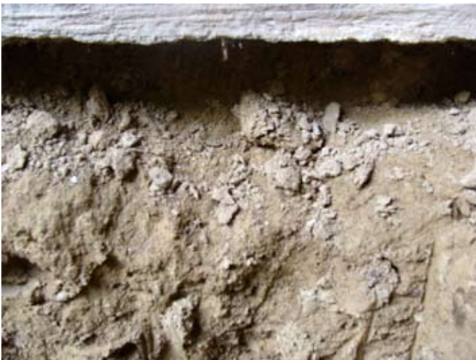
ORT: Heizraumbereich - ohne Horizontal- isolierung: 2015 belüftet
