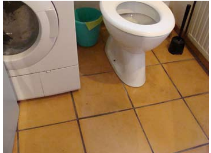
ORT: WC: Wasserschaden: Fehlende H- Isolierung, Siphon, Waschmaschine
