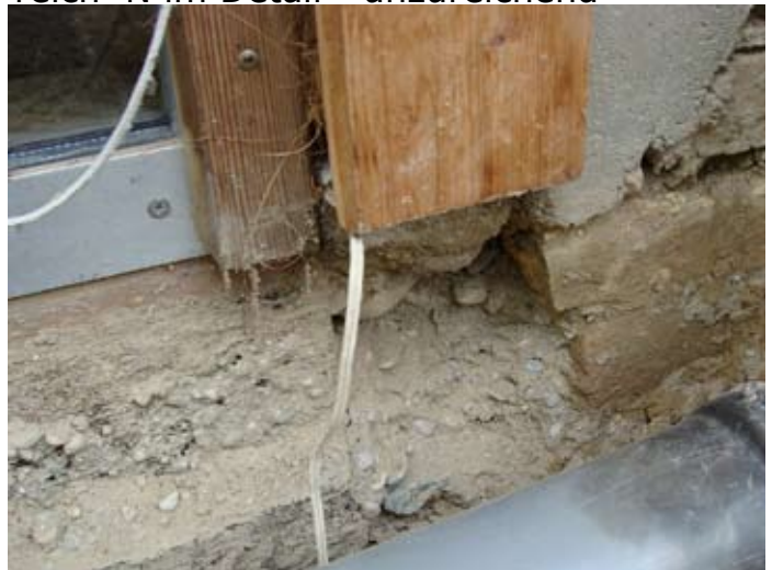
ORT: O-Front - Mangelhafter Anschluss z. Mauerwerk: Ungeziefer/Wasserzugang
