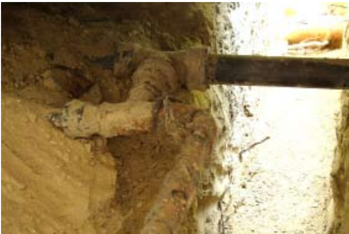
ALT: Wasserleitung - DIREKT unter Niveau. Wohin? ORT: Zwischen Küche 2 und Heizraum
