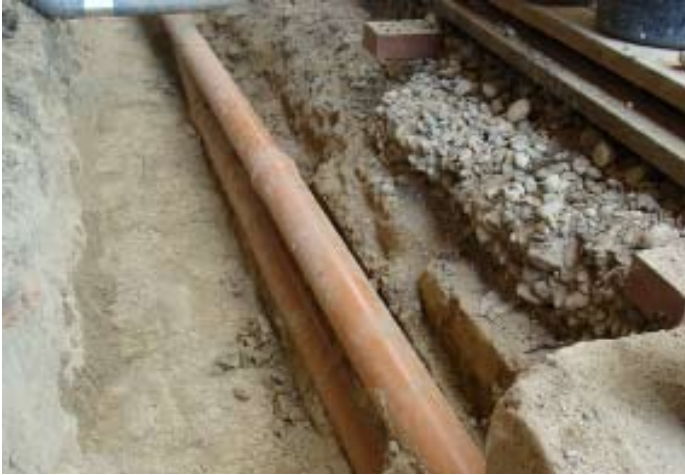
ALT: Endogenes Regenrohr? knapp 20 cm unter Niveau.
