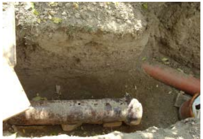
ALT: Toter Steingutabwasserkanal entfernt, um Platz für die neuen Regenrohre und Wasserleitungen zu
