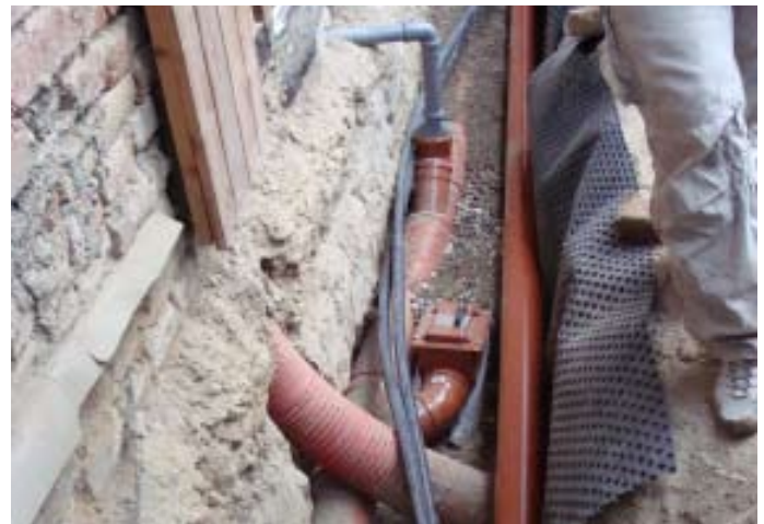
NEU: Regenwasser von Haupt- + Werkstattdach. Rückschlagklappe für Drainageanbindung, Kondenswasser-Anbindung
