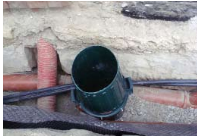
NEU: Rückschlagklappe und Zugang wie beim Standort Lüftungsrohr wurden auch hier platziert.
