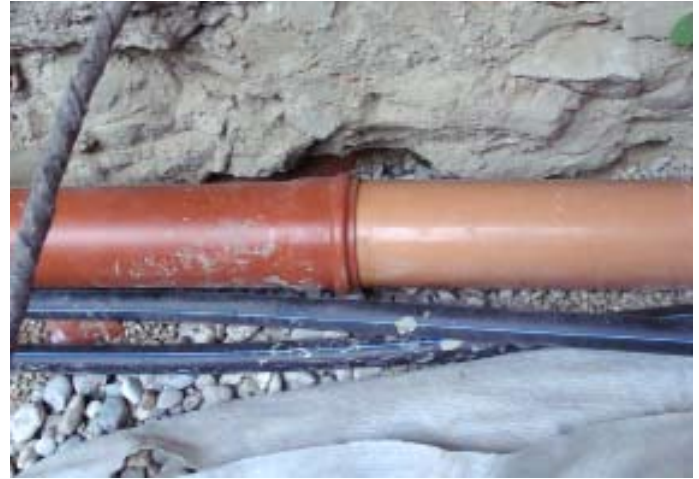
NEU: Einbindung Abwasser 2 in Küche 2. + Drainagerohr Hang und Wasserleitungen. Drainagerohr O-Seite in Flies gehüllt.
