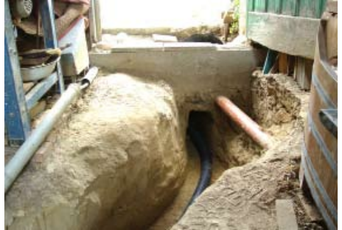
ALT: Drainage-Ableitung 50 cm unter Niveau - weit über Hausniveau führte in die Senk/Sickergrube ?
