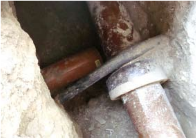
ALT: Steingutabwasserkanal - ORT: Anschluss WC: Gefälle ZUM HAUS! Dicke Ablagerungen im Inneren gefunden
