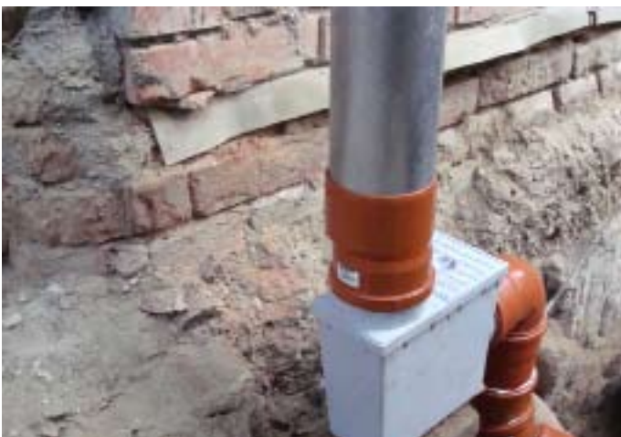
NEU: Regenkasten, wie hier, auch beim Regenrohr bei der Glasfront vor dem Büro.
