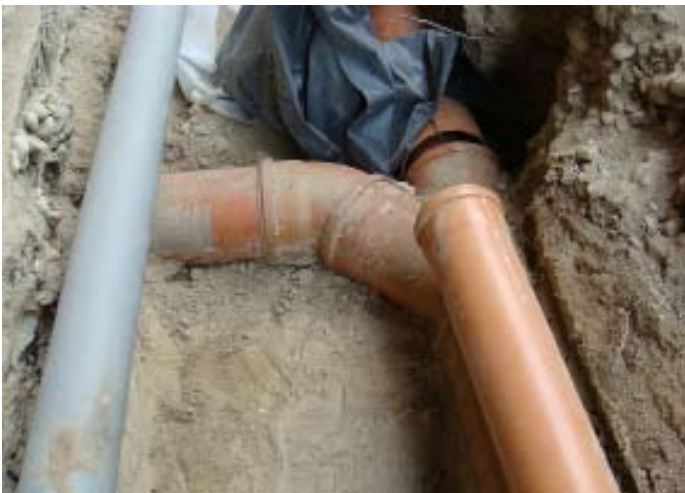
ALT: Regenrohr (grau) setzt sich knapp 20 cm unter Niveau in Kleingartendimension fort
