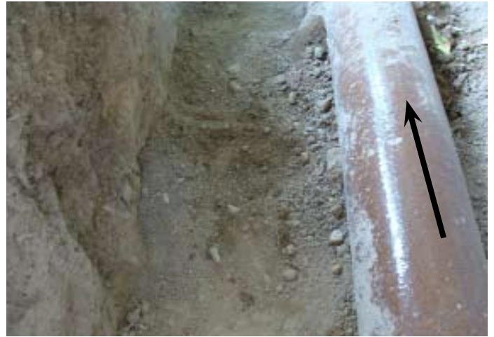
ALT: Steingutabwasserkanal mit kaum Gefälle. Innen bereits dick beschichtet durch den laufenden Rückstau
