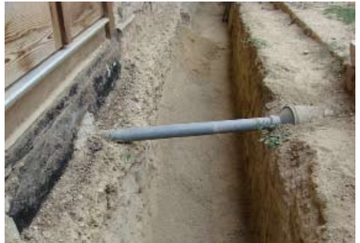
ALT- Kondenswasser vom Lüftungsgerät Ablauf direkt unter der Pflasterung verlaufend
