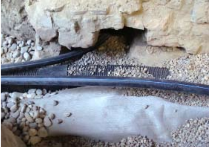
NEU: Drainagerohr im Fliesmantel. Wasserzuleitung vom Heizraum zur Zisterne. Wasser-Transportleitung in den Garten.
