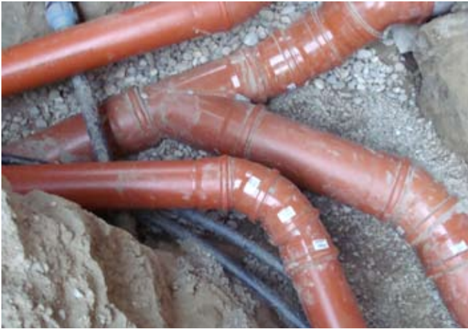
NEU: Knoten WC - Abwasserkanal 1 um ca 30 cm gesenkt. Abwasser 1+ 2 zusammen geführt. Regenwasser extra
