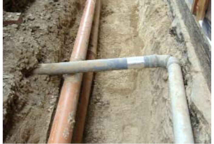
ALT: Regenrohr in Kleingartendimension für 120 m 2 auf ca. 20 cm unter Niveau entdeckt.
