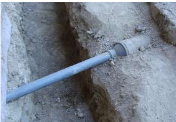
ALT: Kondenswasser vom Lüftungsgerät Anschluss an Abfluss-System Sicker/Senkgrube 2001 direkt unter Pflasterung
