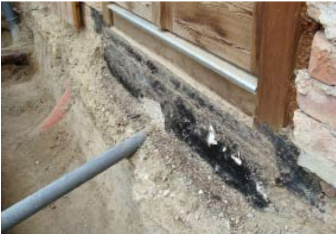
ALT: Kondenswasser vom Lüftungsgerät - Ablauf zur Sicker/Senkgrube Anschluss 2001
