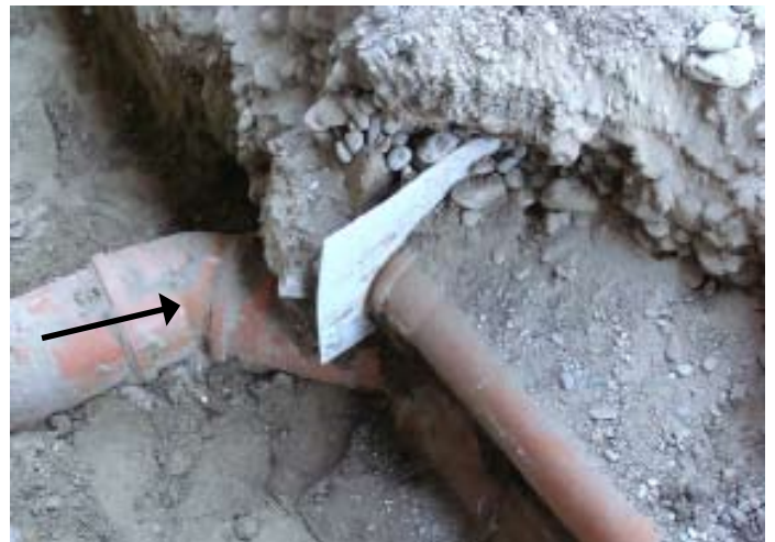
ALT: Abwasserkanal 2 knapp 50 cm unter Niveau, Gefälle wird angzweifelt, da keine Wasserprobe außer Haus ankommt
