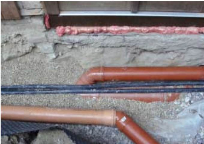
NEU: Knoten Küche 2: Abwasser 2 + Anbindung Drainage, Wasserleitungen + Regenwasserleitung von der Werkstatt
