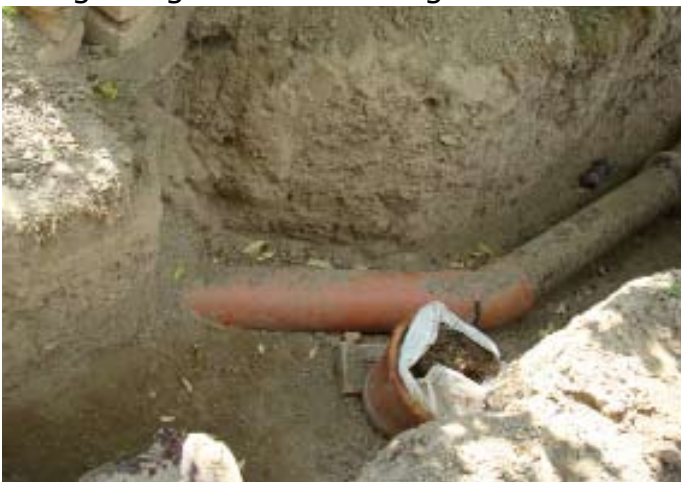
ALT: Vorhandener „NEUER“ Kanalanschluss wird um 25-30 cm tiefer gelegt, für ausreichend Gefälle im Kanal 2
