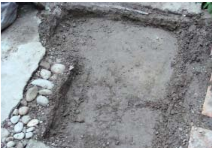
NEU: Wiederherstellung Platzl Innenhof. auffüllen mit Schotter
