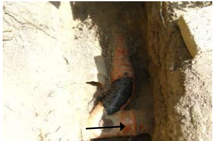
ALT: Regenrohrweiche entgegen der Fließrichtung eingebaut. ORT: Ablauf vor der Werkstatt.
