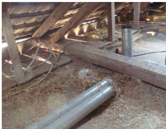
ORT: Schlafzimmer alt, Entlüftung ungesichert INS Dach
