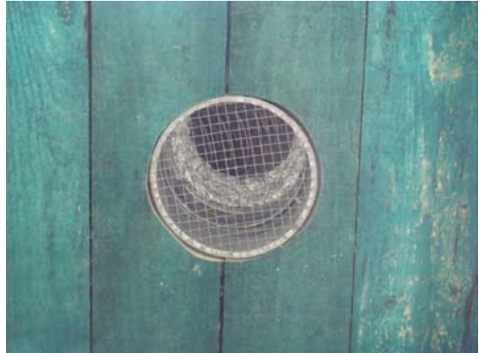
ORT: Laubengang: Abluftventil AUSSEN, gesichert
