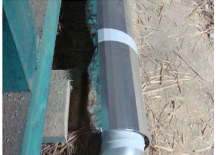
ORT: Neue Leitung - Schalldämmung Ventil Büro
