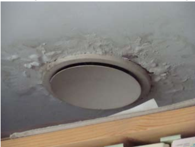
ORT: JU-Ex-Zimmer - Kondenswasser-schaden ab 2011/12
