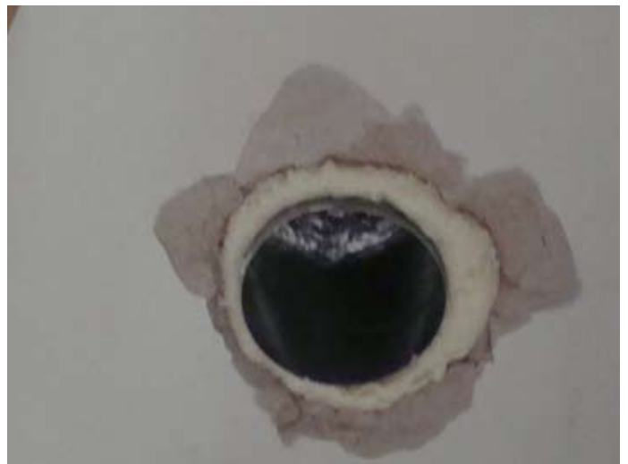
ORT: Ex-Schlafzimmer - DICHTER Ventilanschluss für Wandventil
